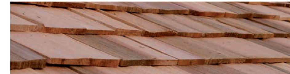
**1 Pente minimum :** quelle que soit la situation géographique de la couverture, la pente ne doit pas être inférieure à 33 % pour une bonne étanchéité. La fibre naturelle du bois fendu sur la surface externe des shakes permet à l'eau (ou la neige) de s'écouler le long des faces de fibres non coupées sans infiltration, avec une absorption minimale d'humidité.
